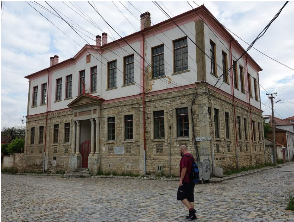
Εικόνα 10 Το κτίριο όπου στεγαζόταν το Μπάγκειο Γυμνάσιον όπως είναι σήμερα. Ακόμη και σήμερα λειτουργεί ως σχολείο, συγκεκριμένα ως αλβανικό λύκειο. (φωτ. Μπάμπουλλας Θεμιστοκλής 2020)
